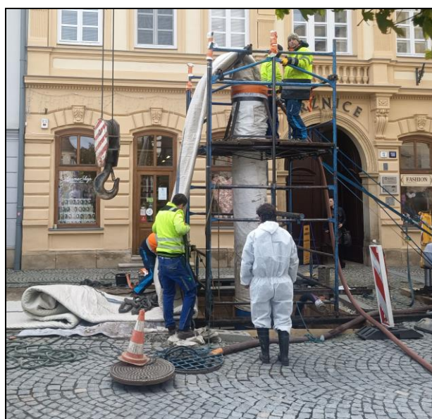
Rozšířená kanalizační šachta, přes níž byl pomocí jeřábu zaváděn textilní rukávec do stávající kanalizace (rozhraní Hlavního náměstí a ulice Čechova, květen 2023). Zhotovitel: BMH spol. s r. o., Olomouc
