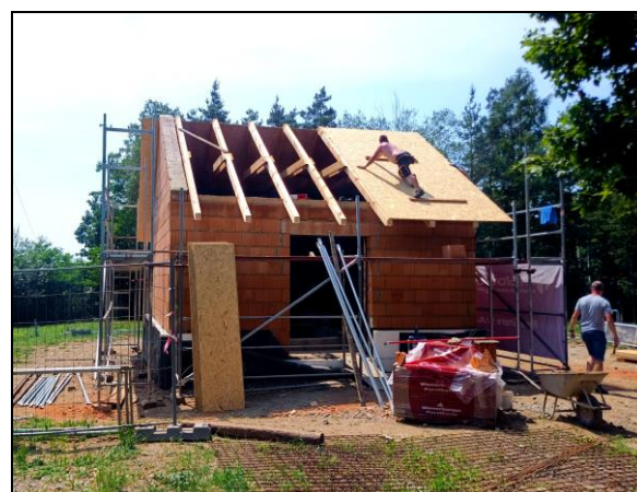
Výstavba nového objektu (červen 2023).
