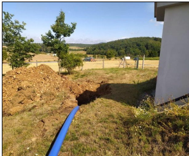
Výměna přívodního vodovodního řadu pro obec Babice metodou řízeného protlaku (srpen 2023).
