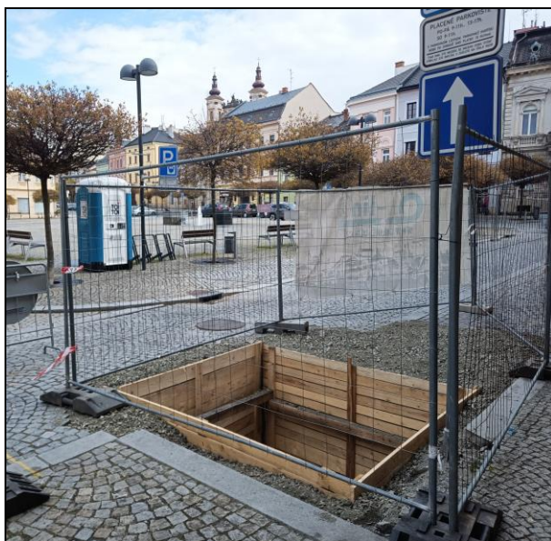
Rozšířená kanalizační šachta, přes níž byl pomocí jeřábu zaváděn textilní rukávec do stávající kanalizace (rozhraní Hlavního náměstí a ulice Čechova, květen 2023). Zhotovitel: BMH spol. s r. o., Olomouc
