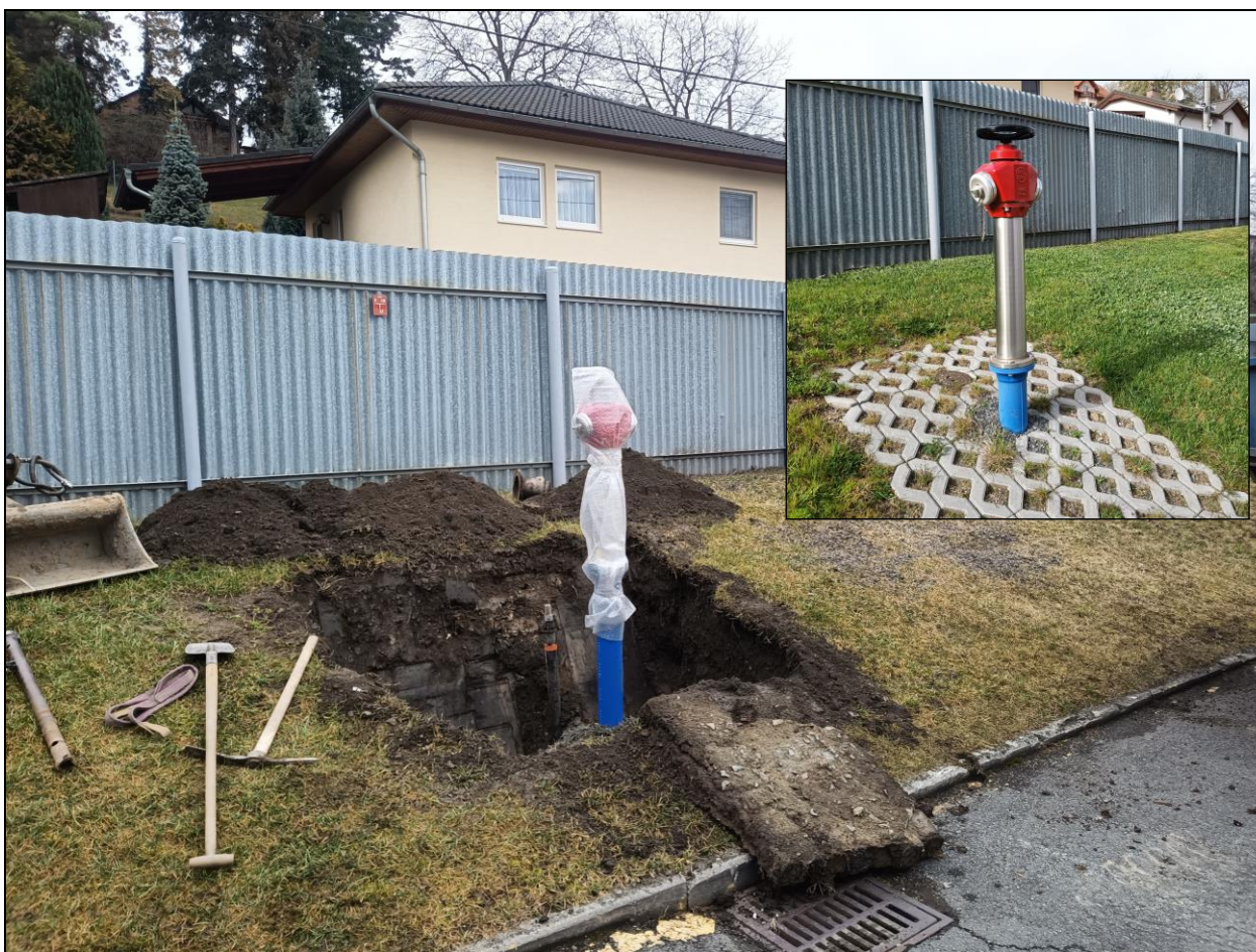
Výměna nadzemního hydrantu sloužícího k plnění cisteren – v areálu společnosti na ul. Vinohradská (únor 2023).
